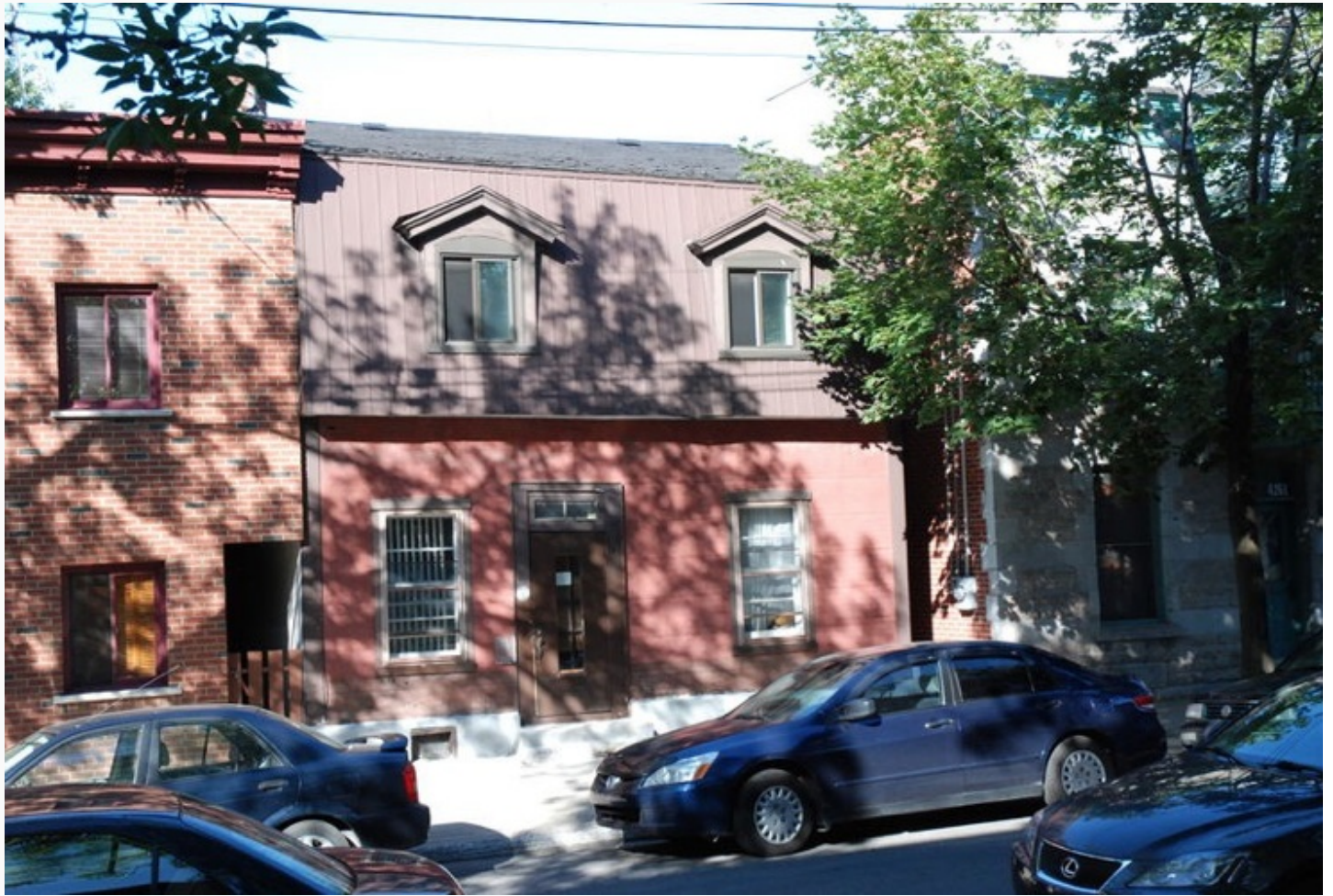
L'immeuble original de la rue Brébeuf est typique des petites maisonnettes des faubourgs. Avec sa construction de bois et son toit en véritable mansarde, elle demeure un des rares témoins de ce développement de la rue Brébeuf qui fut parmi les plus anciens du Village de Saint-Jean-Baptiste. (Photo: Gabriel Deschambault)
